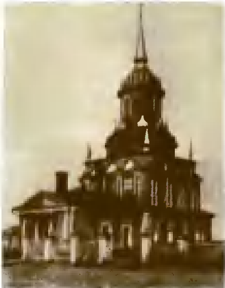
● Никольская церковь в селе Черкизово-Старки.
